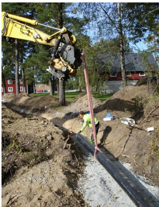
Fjärrvärmenätet byggs ut för att kunna ansluta den nya arenahallen hösten 2014.
