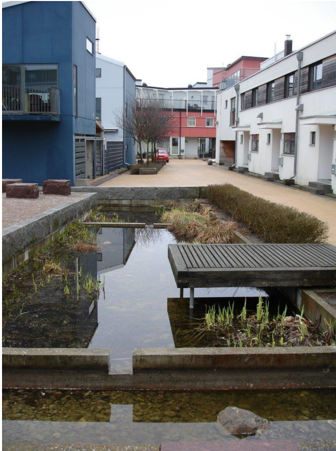
Även inom mycket tät stadsbyggnad går det att lösa dagvattenfrågorna med lokalt omhändertagande. Bild från Västra hamnen i Malmö.
