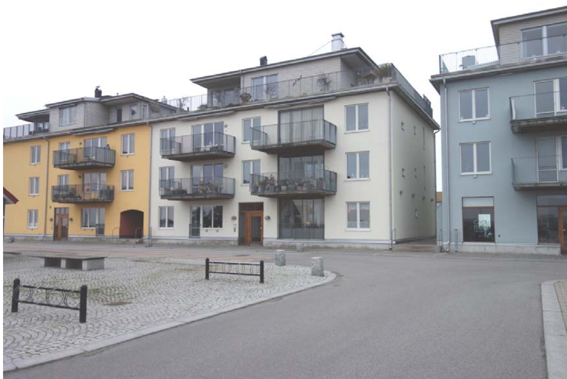
Bebyggelsen ligger nära gatan och har en måttlig skala - 3 våningar med en indragen fjärde våning. Exempel från Lomma.
