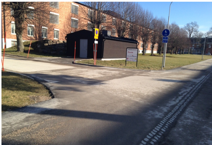
Upphöjd och genomgående gång- och cykelväg längs Visborgsallén
