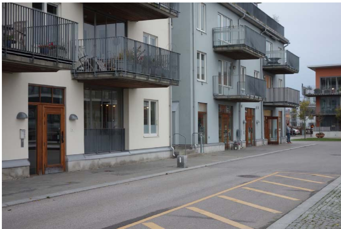
Möjligheter till en blandning av bostäder och verksamheter i bottenvåningarna. Exempel från Lomma
